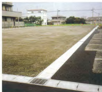
大藪小北側に完成した駐車場
