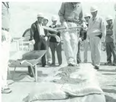
堤防の応急復旧のための積み土のう
