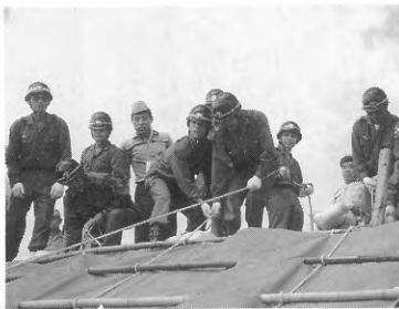
シート張り (洗掘防止)
