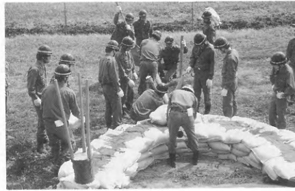
釜段工 (漏水防止)
