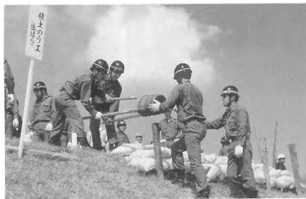
積土のう工 (決壊・崩壊防止)
