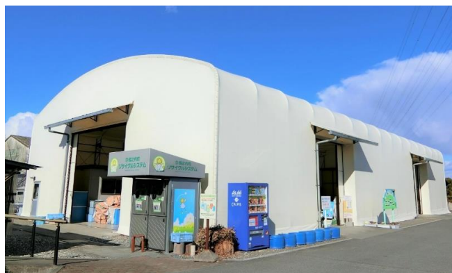
図7 エコドームの外観（出典：輪之内町資料）
